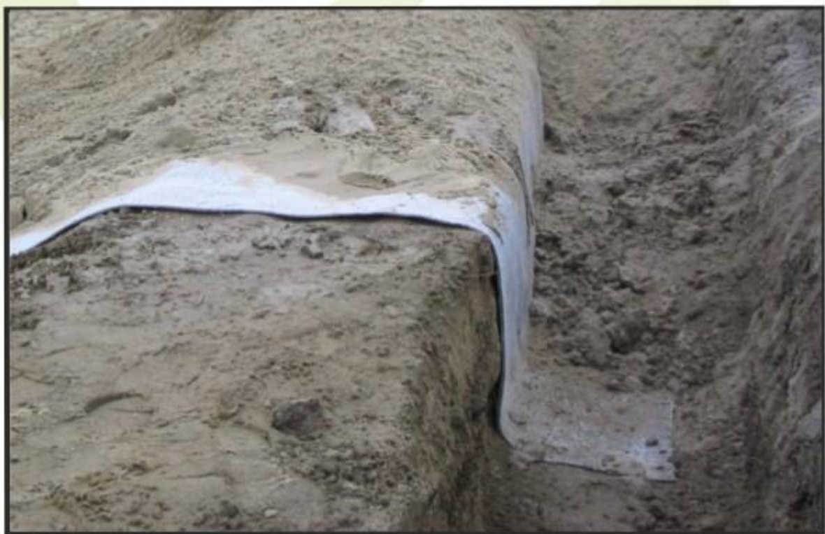
Рис. 2 Устройство анкерного замка
