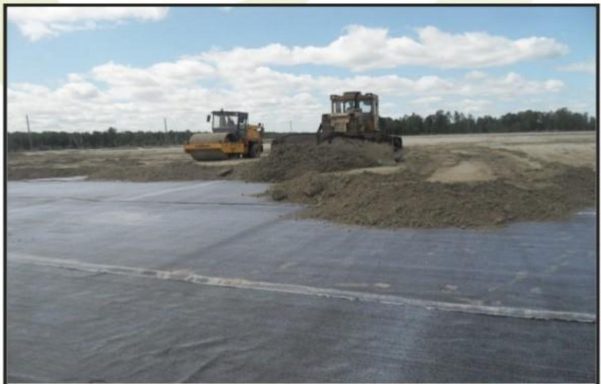
Рис. 6 Устройство обратной засыпки
