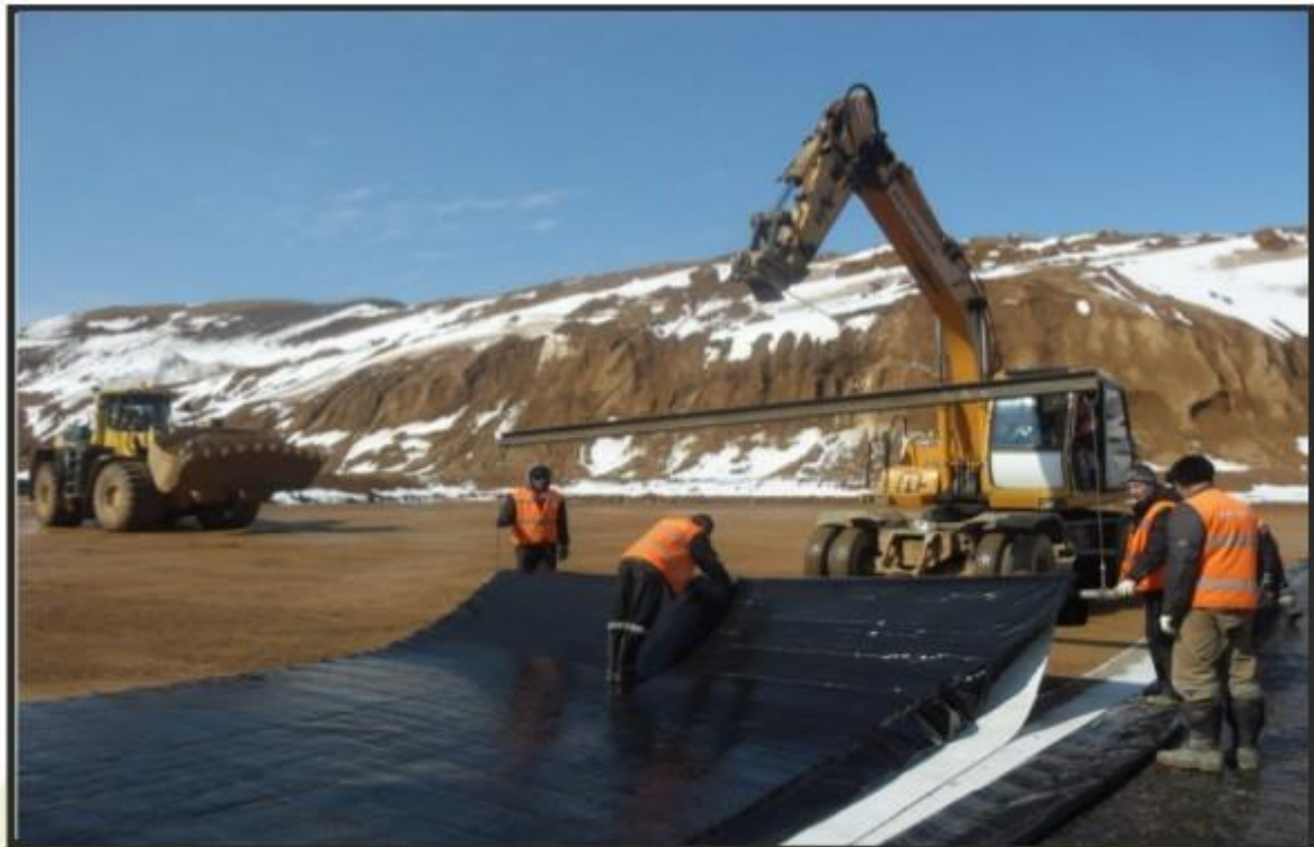
Рис. 3 Укладка бентонитового мата
