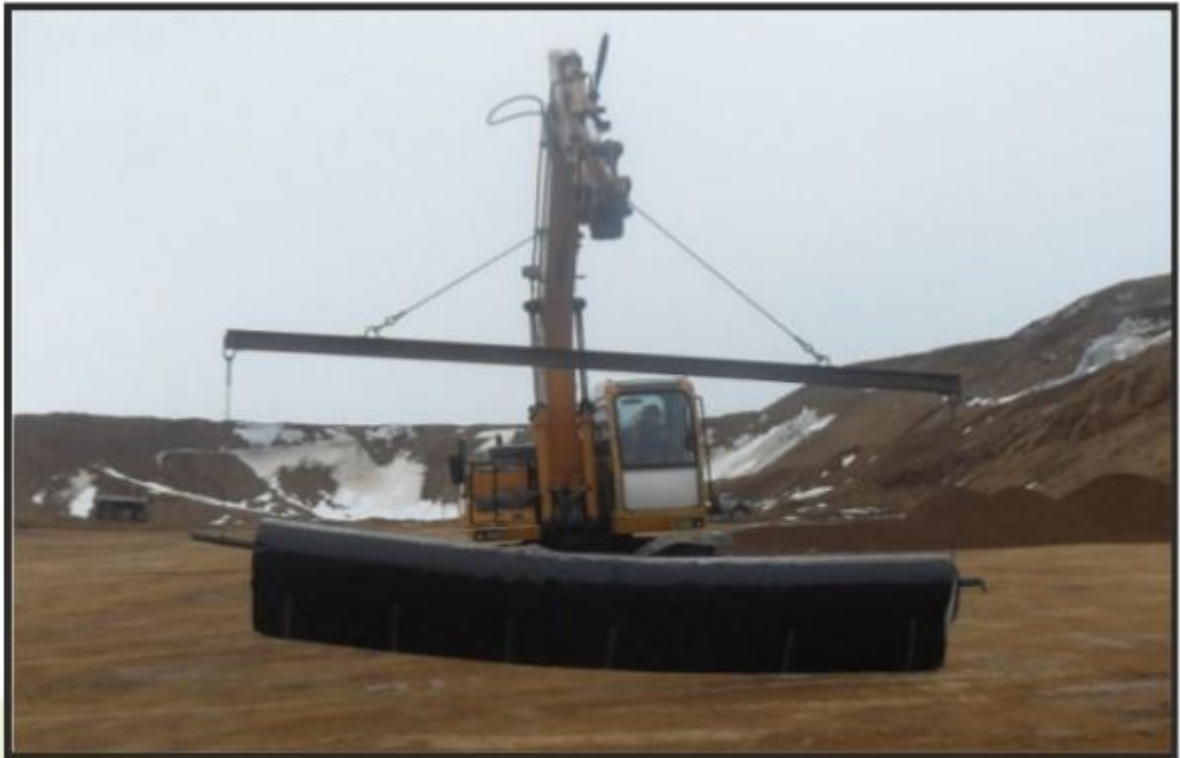
Рис. 1 Траверса для транспортировки и укладки рулонов бентонитового мата
