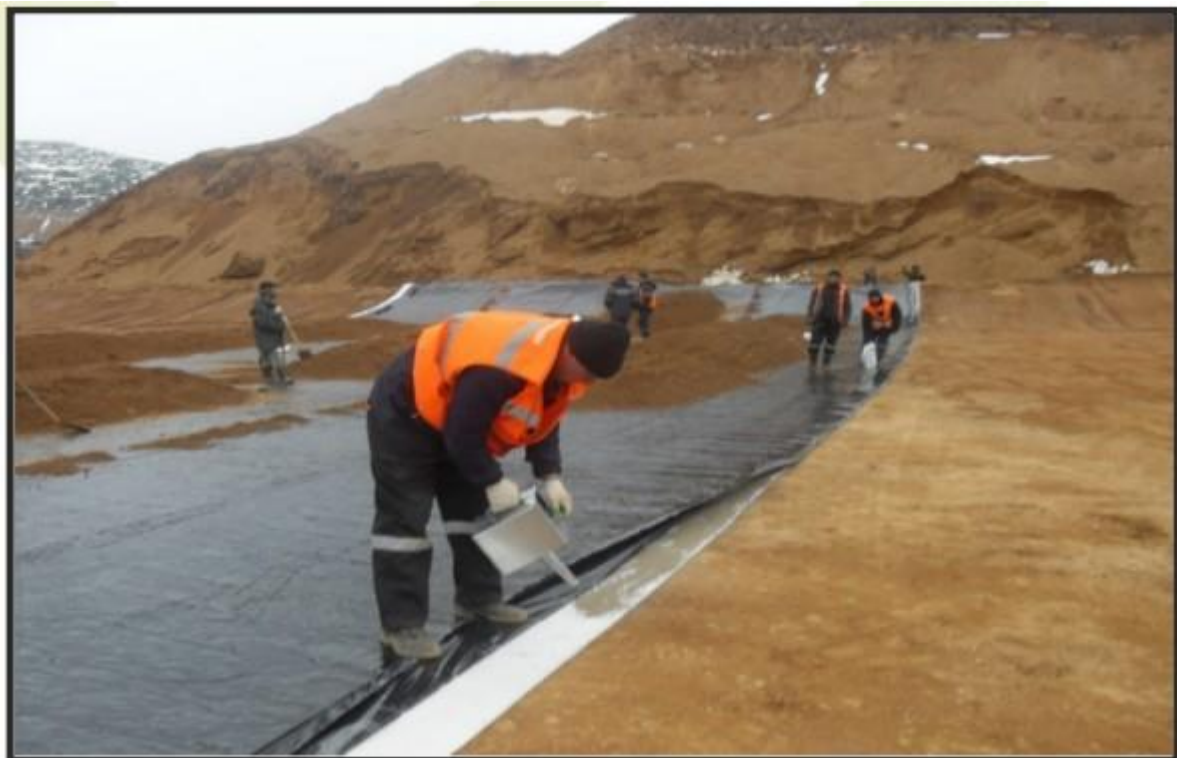
Рис. 4. Просыпка зоны нахлеста бентонитовыми гранулами
